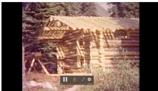
Figura 12 – Frame do filme no momento em que o protagonista constrói o telhado.
