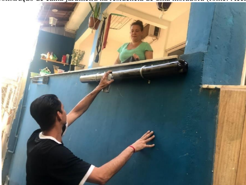
Figura 2. Construção de calha jardineira na residência de uma moradora (fonte: Acervo pessoal).
