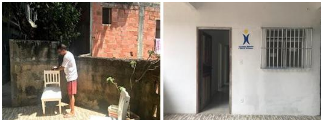
Figuras 33 e 34: Salão principal da Horizonte antes da intervenção, 2022.
