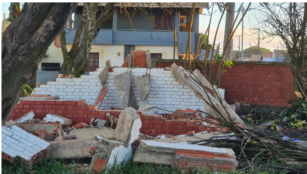
Figura 44: Destroços de uma casa em Atafona. Fonte: a autora. Data: fevereiro de 2024
